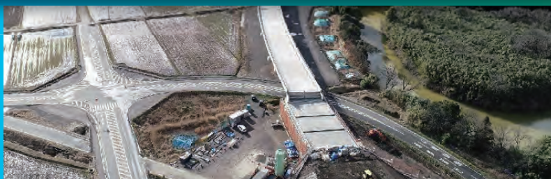
あかみず 赤水地区 黒川高架橋 工事状況
