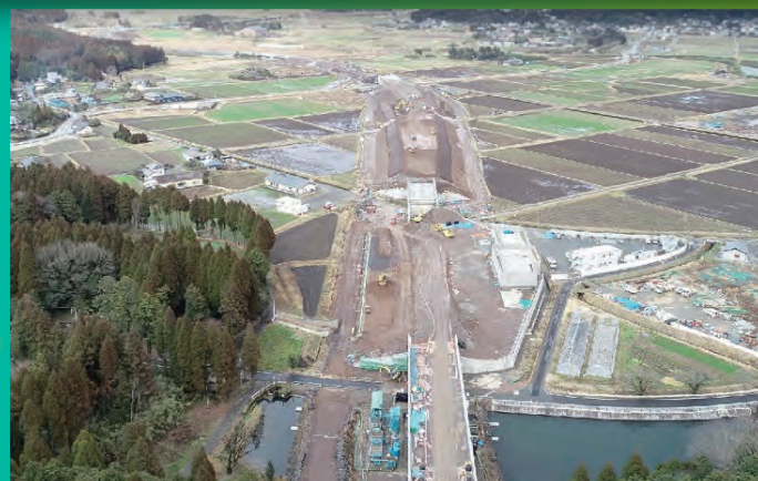
こうぐち 阿蘇側坑口付近工事状況
