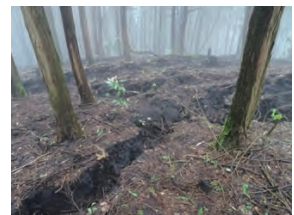
写真③ 崩壊面周囲の亀裂
