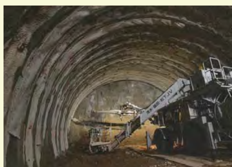
▲掘削工事の様子 (平成29年11月27日)
