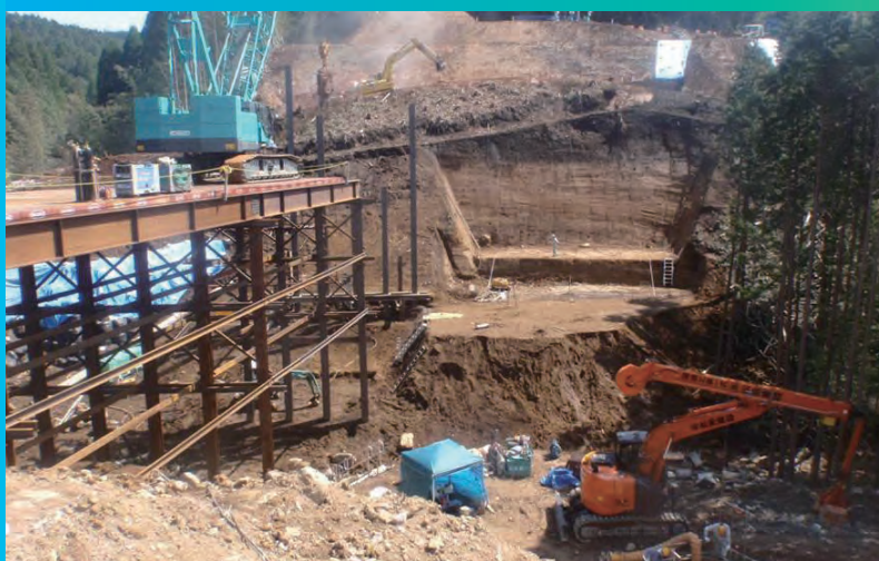
ふるじょうちく 古城地区工事用道路工事
