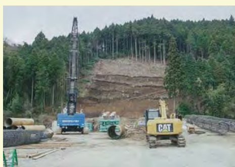
▲二重峠トンネル阿蘇市側の坑口予定地の様子 (平成29年4月24日)
