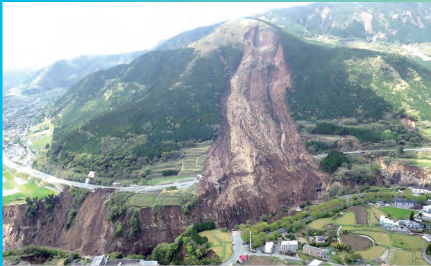
国道 57 号の大規模斜面崩壊
