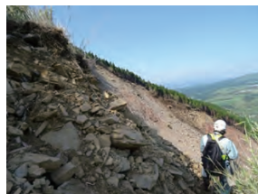
写真① ちょうぶかつらがいい 頂部滑落崖の状況
