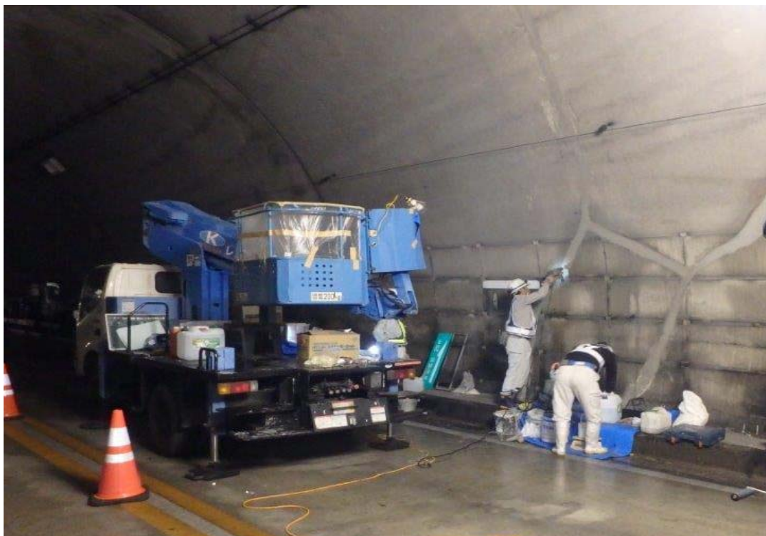
トンネル覆工のひび割れ補修
