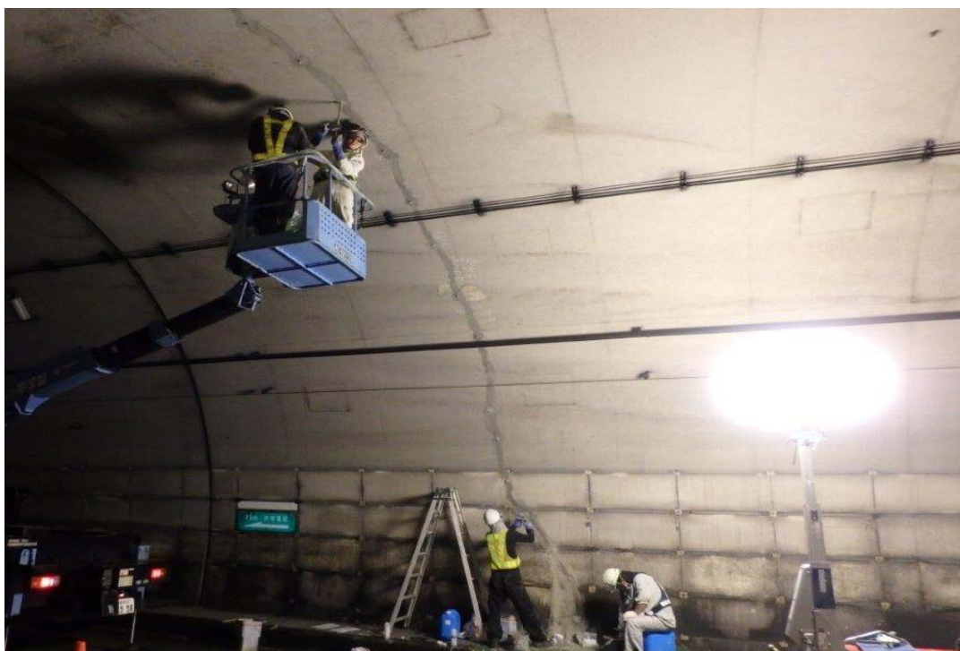
覆工背面への裏込め注入
