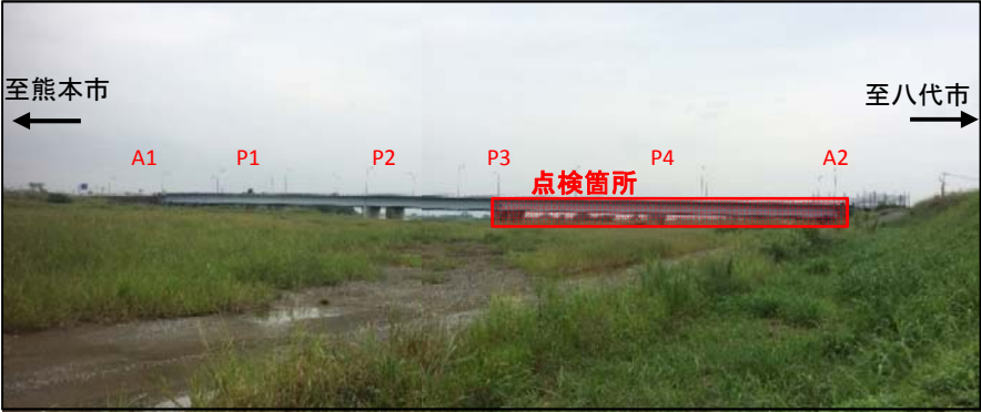
緑川橋（上り） 状況写真
