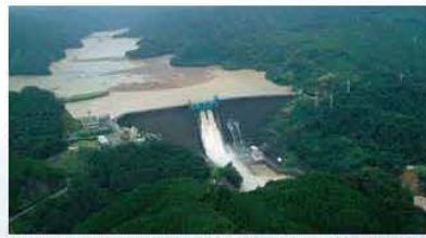
異常洪水時防災操作を行っている鶴田ダム（平成18年7月出水）
