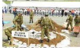
鹿上自衛隊第8施設大隊：盛土工
