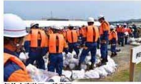
伊佐市消防団：盛土工
