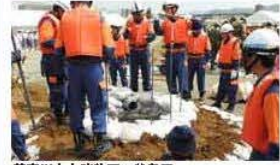
鹿座川内市消防団：盛土工
