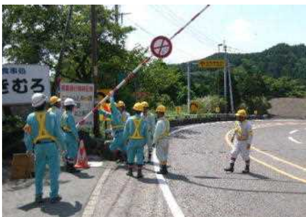
【遮断機操作訓練の状況】
