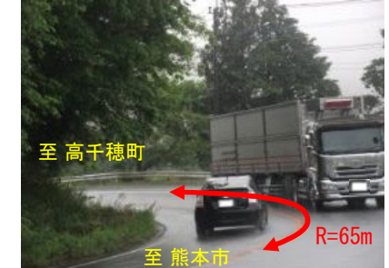
▲線形が厳しい箇所(写真③)
