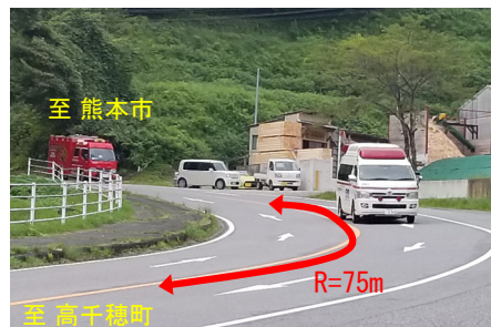
▲線形が厳しい箇所(写真①)
