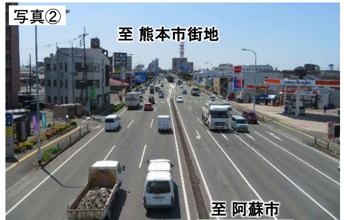
▲ 国道57号熊本東バイパス (6車線開通済)
