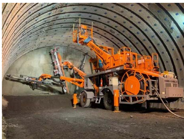
滝室坂トンネル
