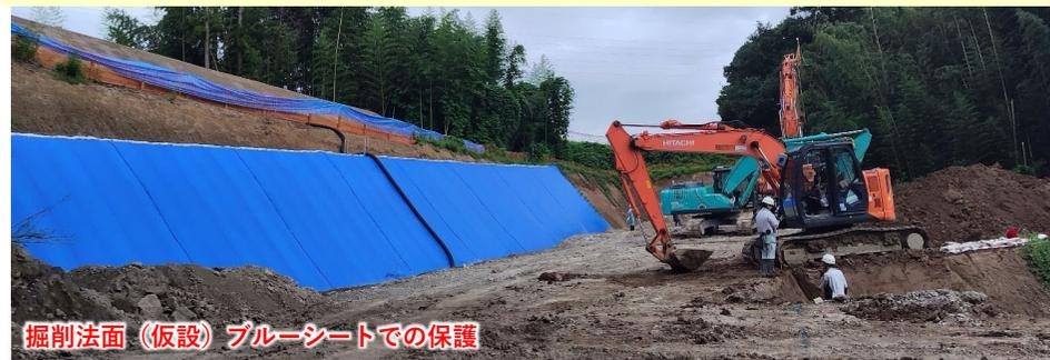
掘削法面（仮設）ブルーシートでの保護
