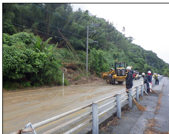
57号 147k600下り線 道路への土砂流入箇所の啓開作業
