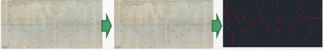
ひびみつけは、撮影した写真を合成し損傷検出を行い、CAD図として出力できます。
