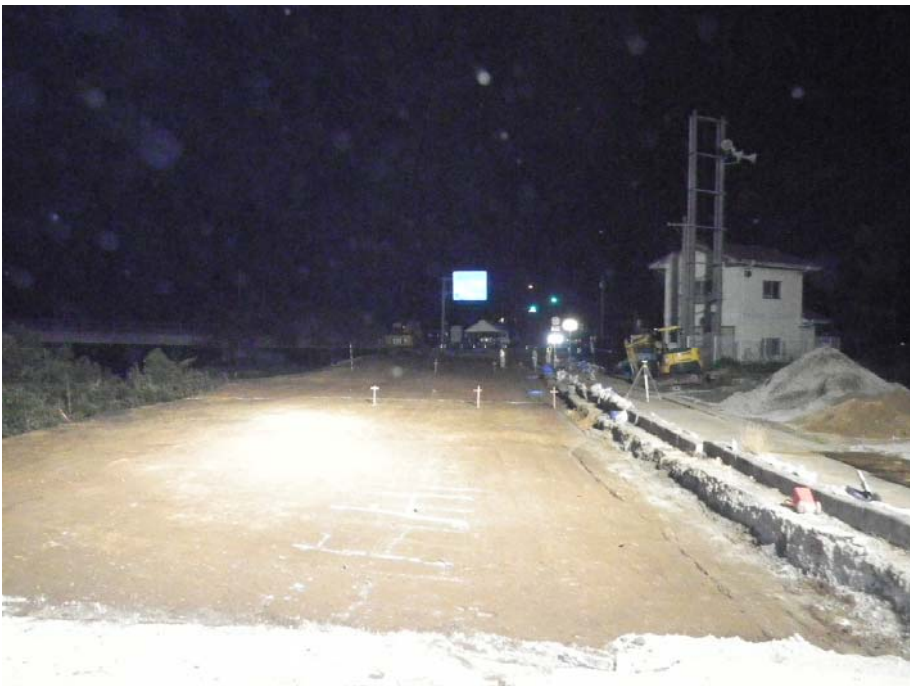
盛土完了（平成28年4月21日撮影）
