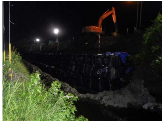
施工状況（夜間作業）
