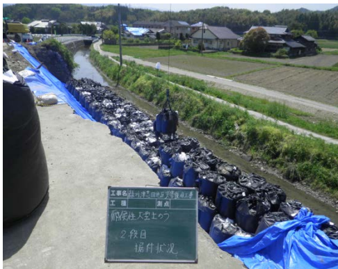
施工状況（昼間作業）
