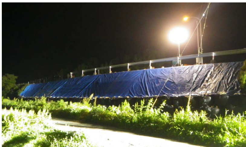
完了（平成 28 年 4 月 23 日撮影）
