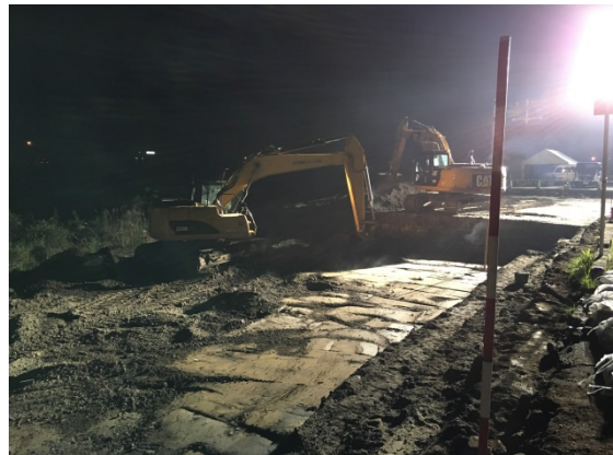
施工状況（夜間作業）
