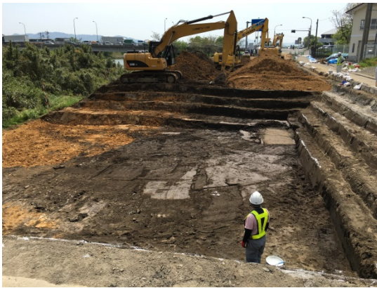
施工状況（昼間作業）
