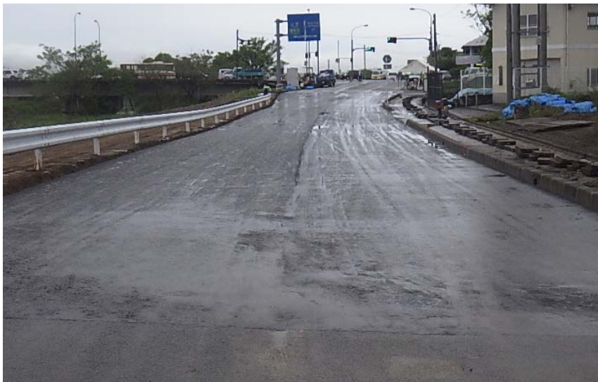
完了（平成 28 年 4 月 27 日撮影）
