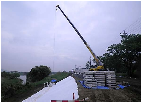
施工状況（昼間作業）
