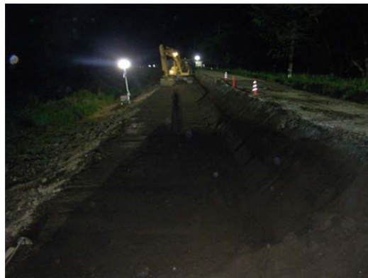
施工状況（夜間作業）
