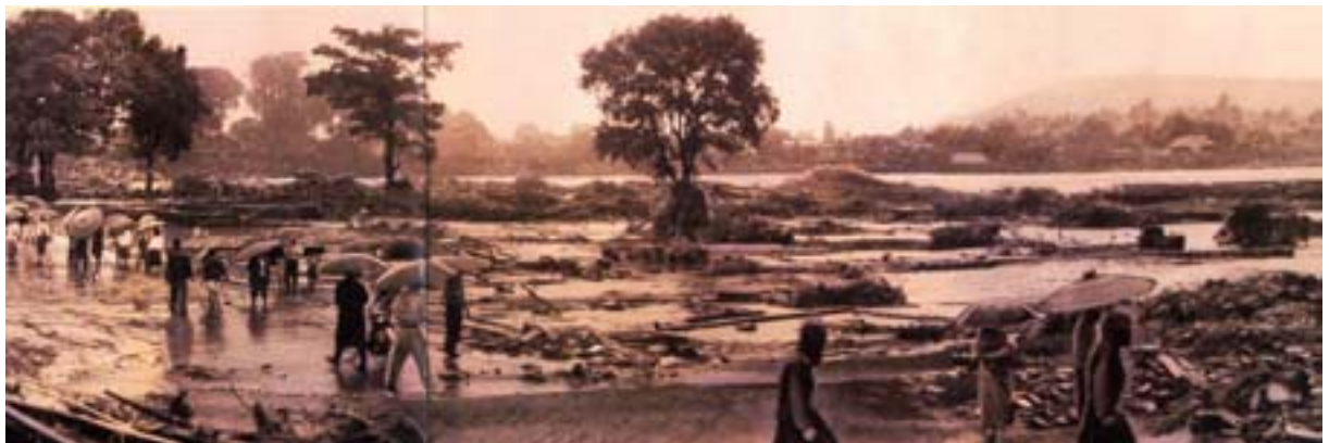
熊本市大江地区の被害状況（昭和28年6月26日（1953.6.26）の大洪水）
