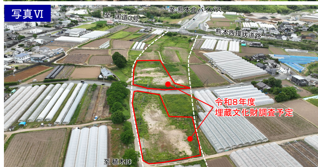
埋蔵文化財調査の状況
