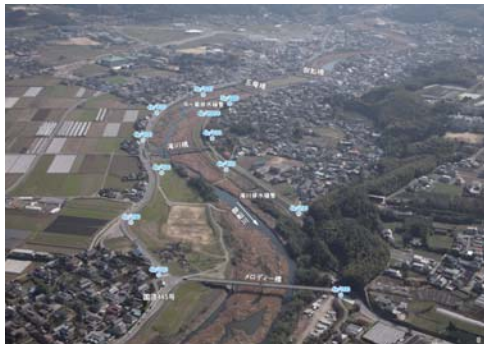
写真-2. 2. 5 土砂堆積状況 (4k000~5k000付近)
