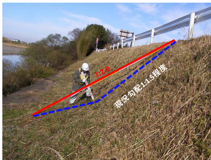
写真-2.3.2 寺勾配状況
