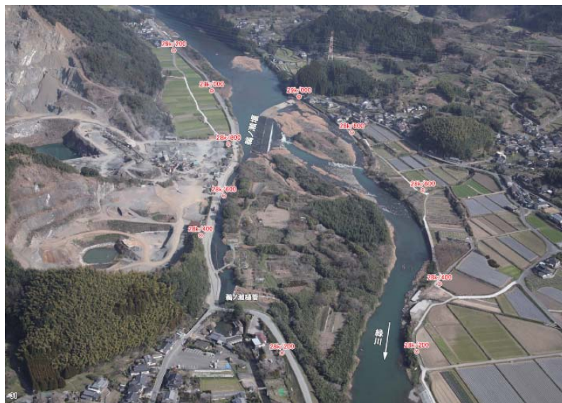
写真－2. 1. 2 上流部樹木繁茂状況
