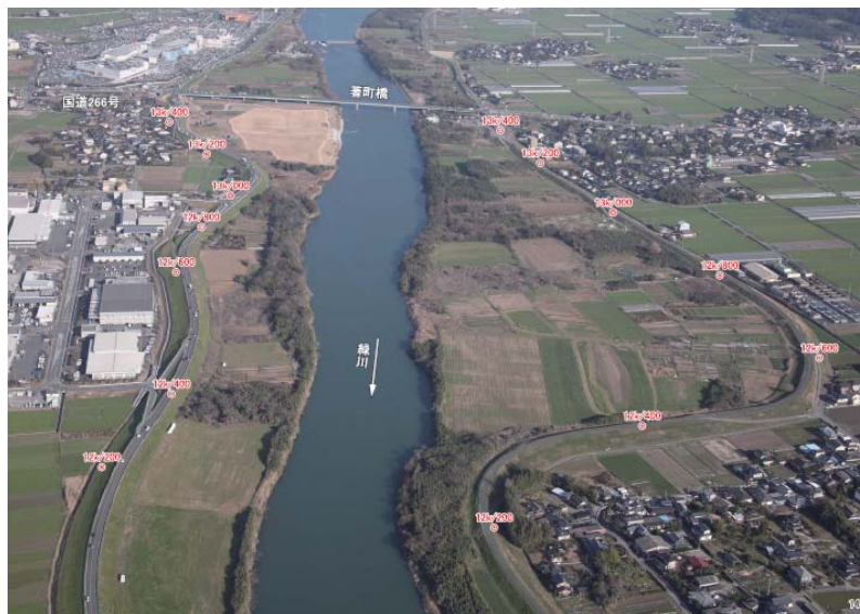
写真－2. 1. 1 中流部樹木繁茂状況
