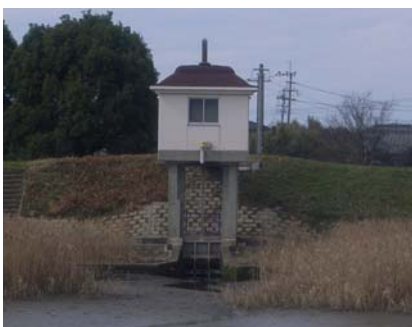
写真-2.4.5 樋門外観状況
