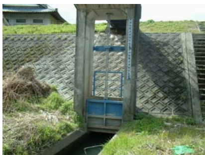
写真-2.4.3 樋門外観状況
