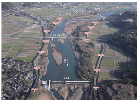
写真－2. 2. 1 堰周辺土砂堆積状況 (糸田堰 ～ 麻生原堰付近)
