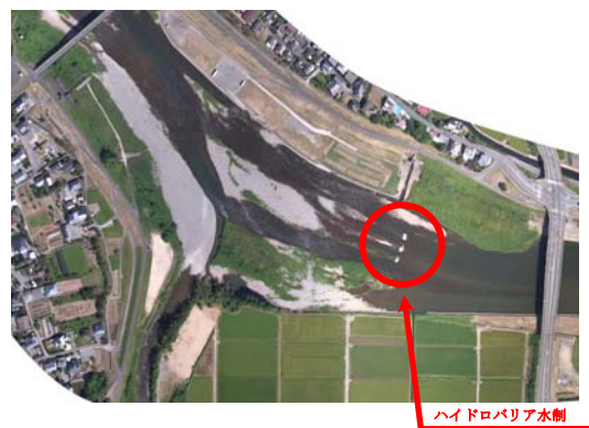
写真－2. 2. 4 津留川合流点堆積状況 ( hidrobarrier 水制設置後)
