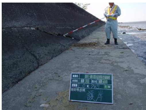
写真-2.5.1 緑川河口特殊堤 (左岸 0k750 付近)
