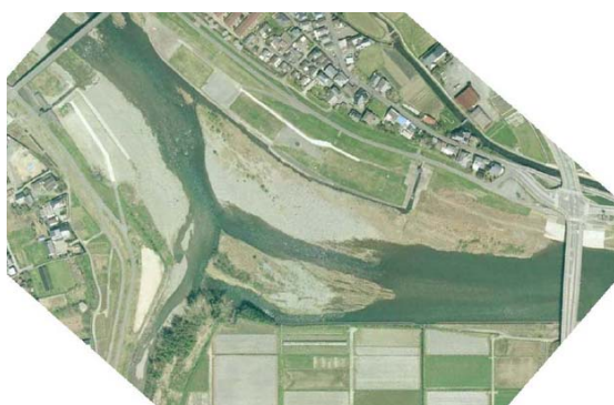
写真－2. 2. 3 津留川合流点堆積状況 ( hidrobarrier 水制設置前)
