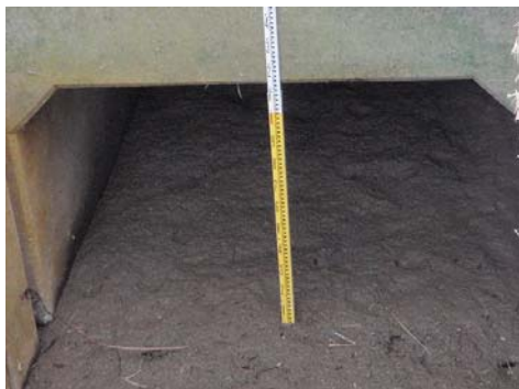
写真-2. 2. 7 ガタ土堆積状況 (殿井排水樋管)
