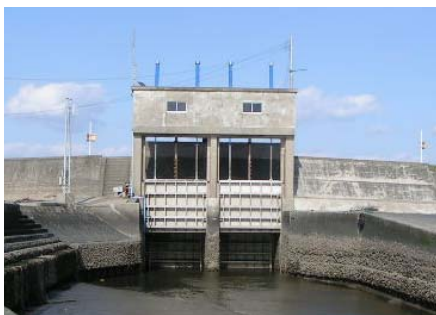
写真-2.4.1 樋門外観状況
