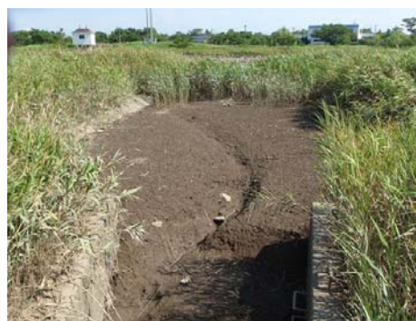
写真-2. 2. 8 ガタ土堆積状況 (渡場排水樋管)
