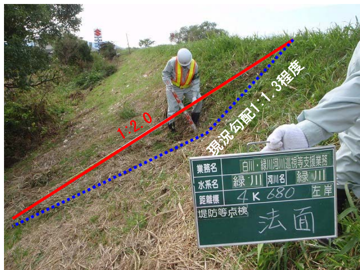
写真-2.3.1 寺勾配状況
