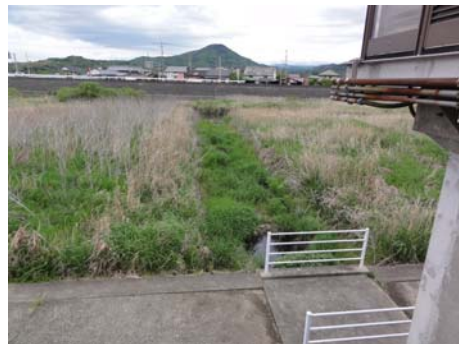
写真-2. 2. 6 樋管前面堆積状況 (牛ヶ瀬排水樋管)
