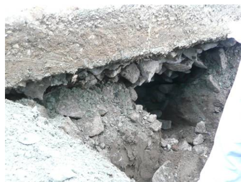
写真-2.3.4 堤体材料の吸い出し
