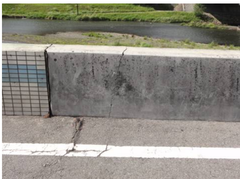
写真-2.3.1 特殊堤の亀裂
