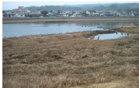
写真－2. 1. 4 小碓水辺公園：堆積状況 (左岸 17k000 付近)
