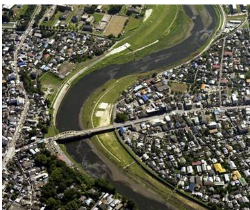
写真－2. 1. 5 子飼橋左岸堆積状況 左岸 14k600 堆積前
