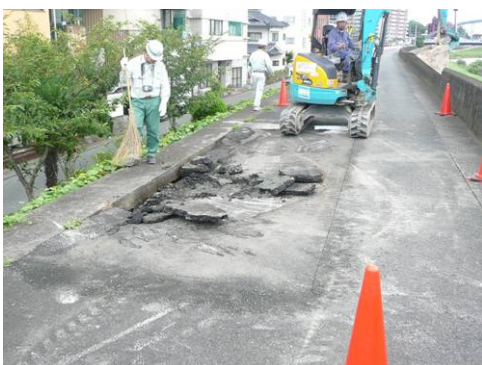
写真-2.3.3 特殊堤天端の変状
