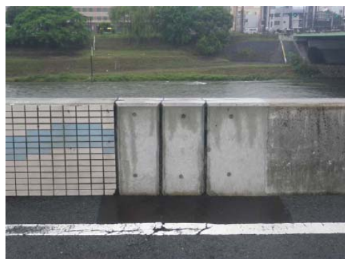
写真-2.3.2 特殊堤の補修後
