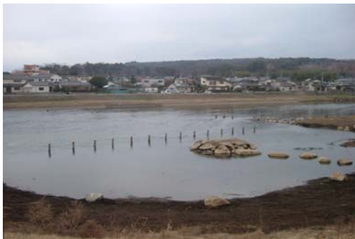
写真－2. 1. 3 小碓水辺公園：堆積前 (左岸 17k000 付近)
