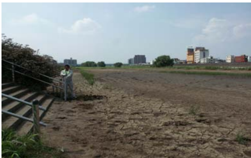
写真－2. 1. 1 白川橋下流左岸：ヨナの堆積状況 (10k600 付近)
