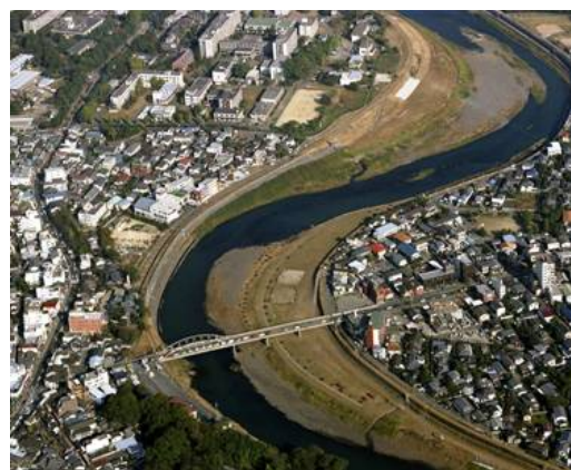
写真－2. 1. 6 子飼橋左岸堆積状況 左岸 14k600 堆積状況
