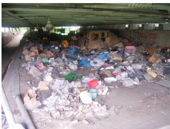
写真－2. 5. 3 市街部橋梁下ゴミ
