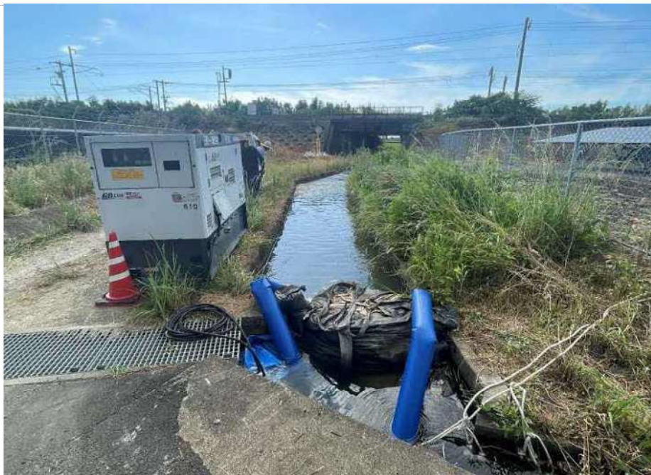
仮設ポンプ設置
