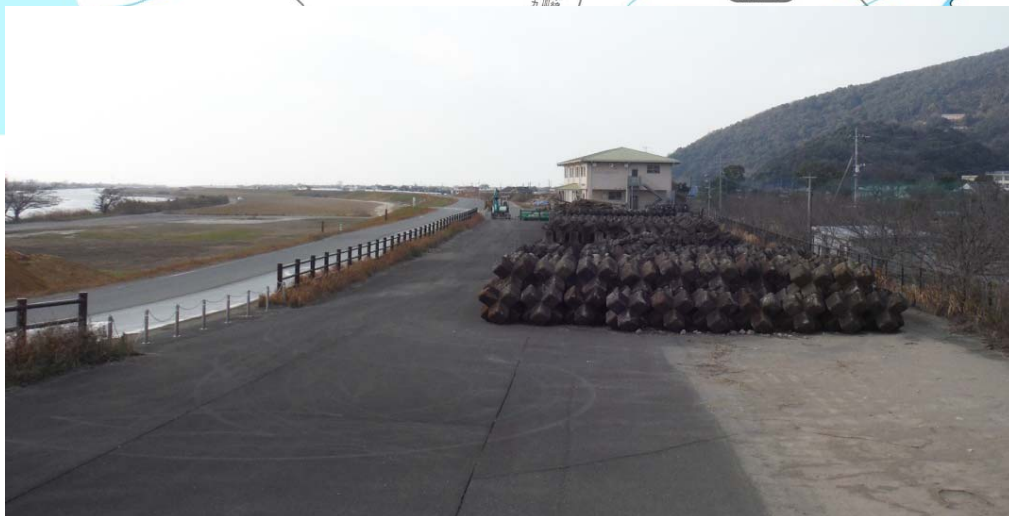
水防資機材(根固ブロック)整備状況
