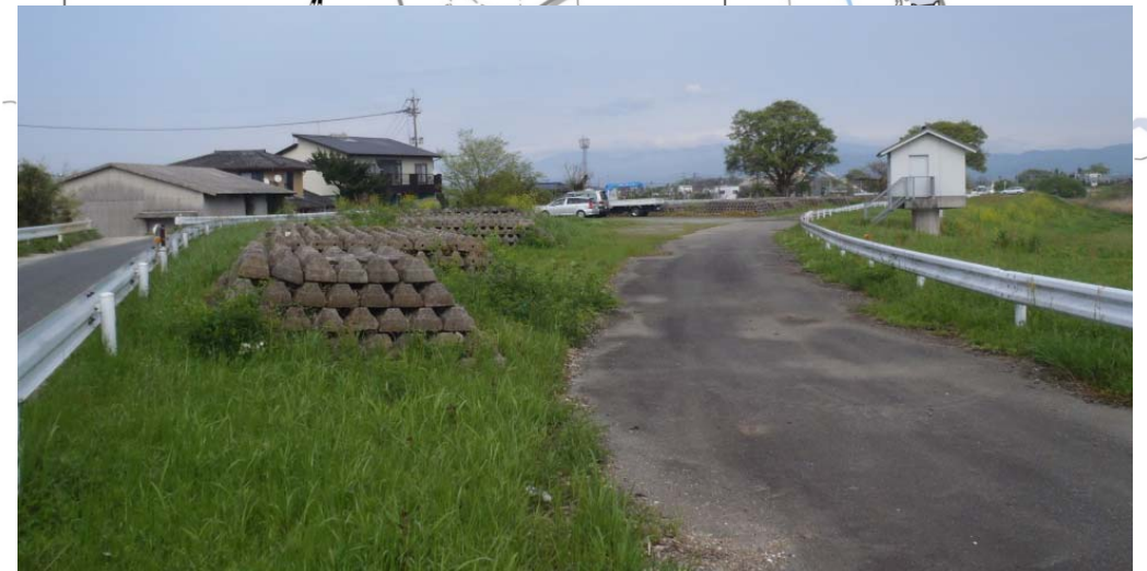
水防資機材(連節ブロック)整備状況
