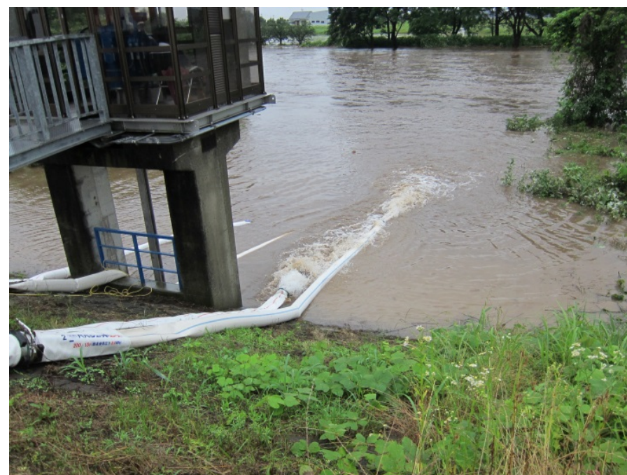
御船川における内水被害状況(H27.6 御船町滝川地区)
