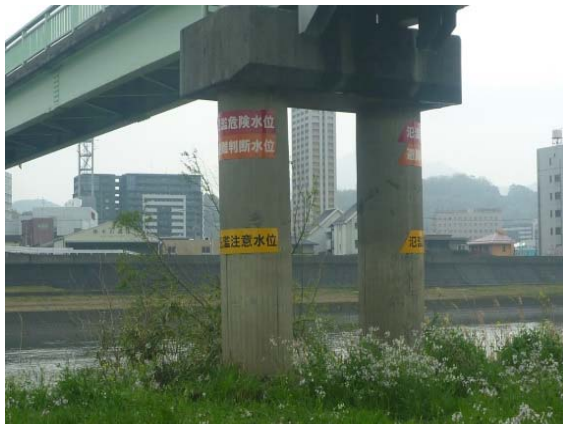
白川:世安橋への危険度レベル標識設置状況
