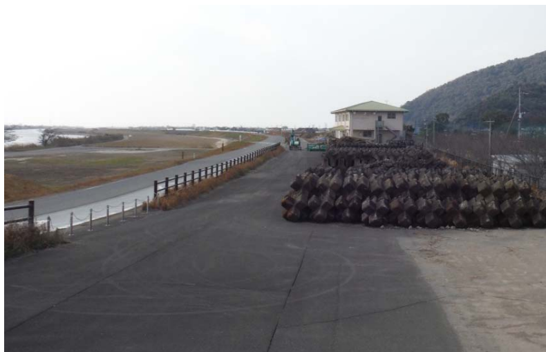
水防資機材(根固ブロック)整備状況
