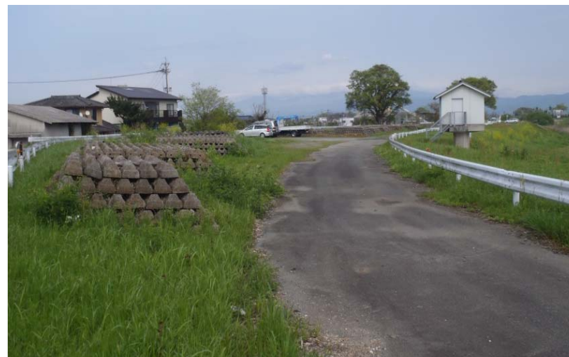
水防資機材(連節ブロック)整備状況
