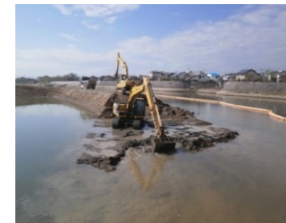
加勢川 河道掘削 施工状況
