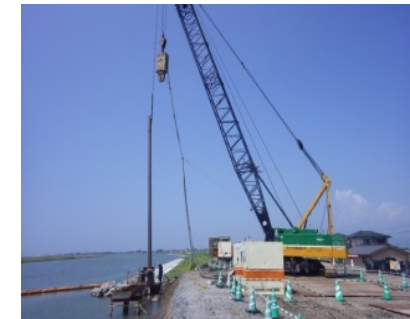
緑川河口・浜戸川 鋼矢板 施工状況
