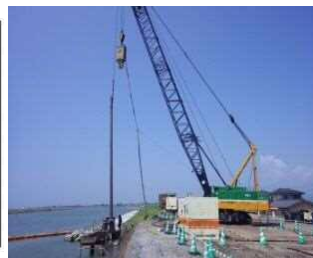
緑川河口・浜戸川 鋼矢板 施工状況
