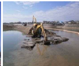
加勢川 河道掘削 施工状況
