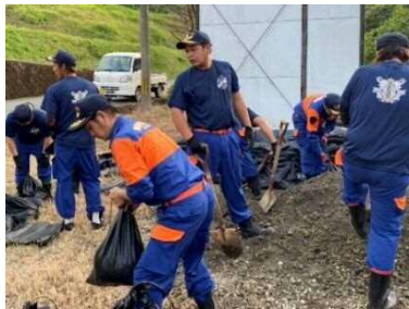
水防団の土のう作製【御船町】
