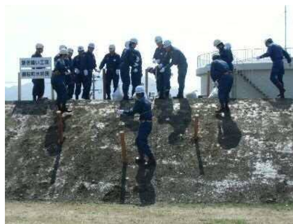
繋ぎ縫い工法を実施する御船町水防団(御船町)
