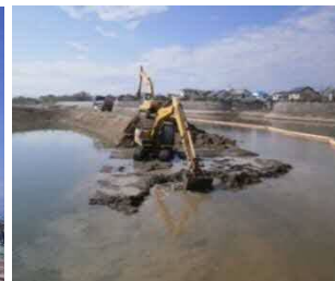
加勢川 河道掘削 施工状況
