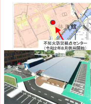
不知火防災拠点センター【宇城市】
