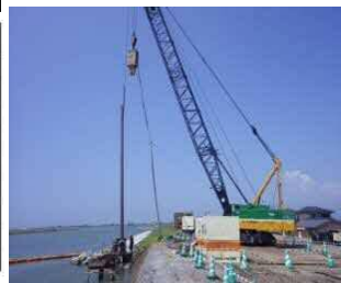
緑川河口・浜戸川 鋼矢板 施工状況
