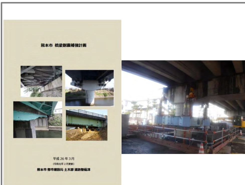
熊本市橋梁耐震補強計画(写真左) 国道266号(八王寺跨線橋)耐震補強工事(写真右)
