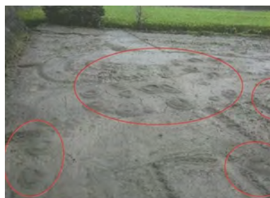
漏水による噴砂の例
