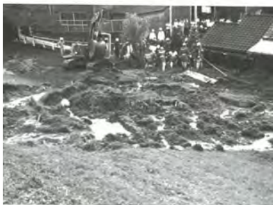
排水不良による法すべり
