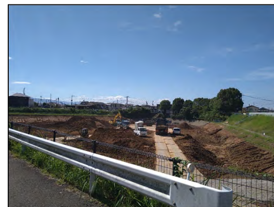
既存調整池容量拡充の状況(鶯川調整池)
