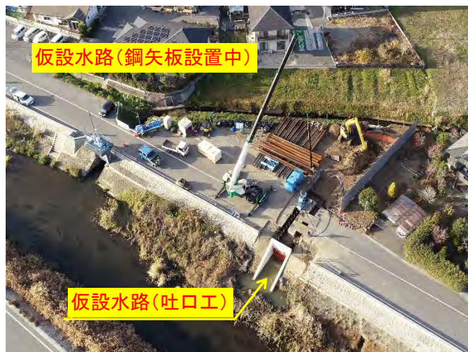
施工状況(仮設水路設置)
