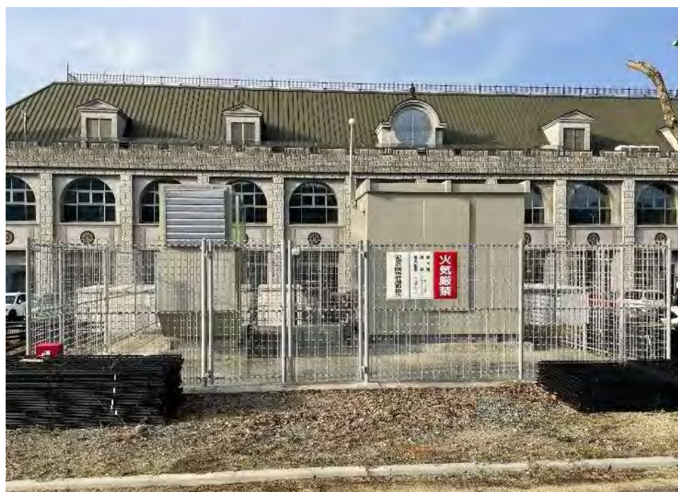
中央庁舎非常用電源
