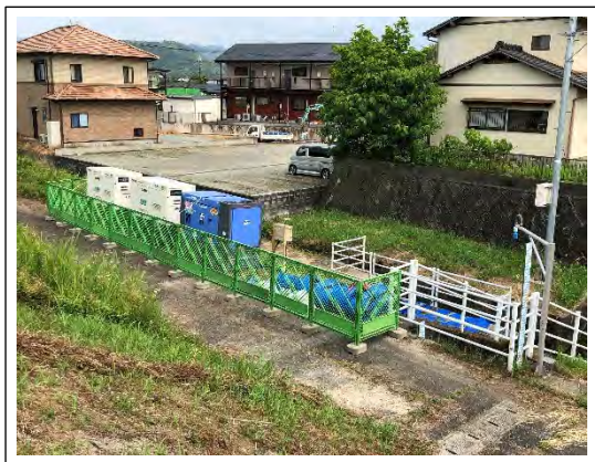
令和3年度設置状況
