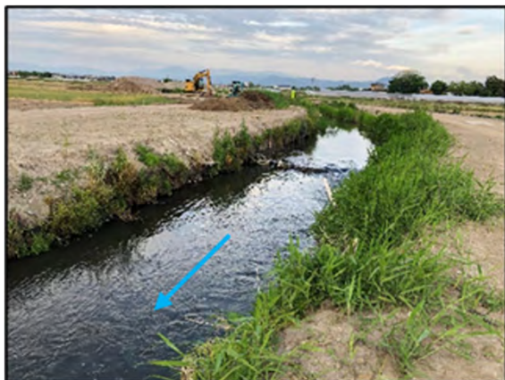
【整備前】河道拡幅(旧天明新川)
