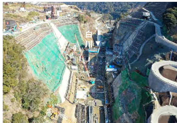
立野ダムの工事状況(令和4年2月) (下流側より望む)
