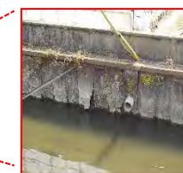
腐食した鋼矢板
