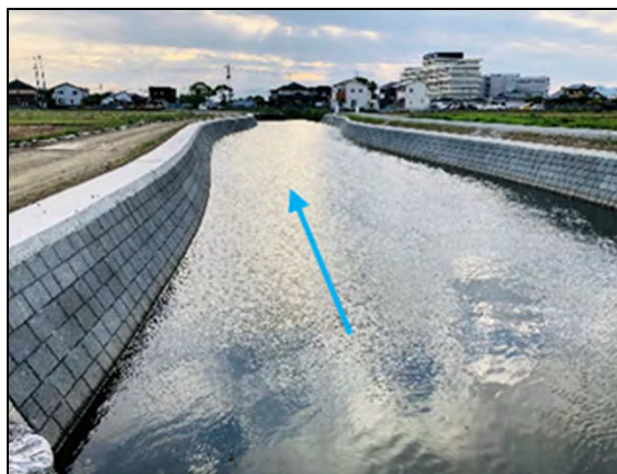
【整備後】河道拡幅(旧天明新川)
