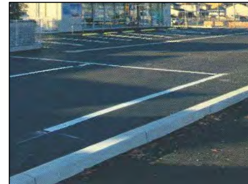
駐車場内の透水性舗装施工例
