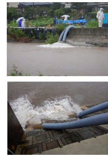
仮設ポンプによる排水状況
