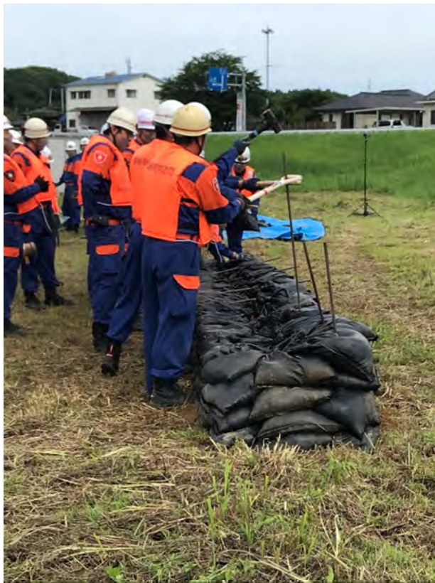
土嚢積み工法
