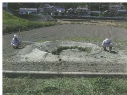
漏水による噴砂の例
