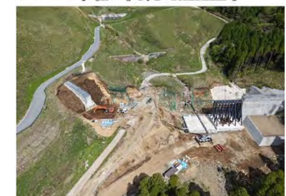
西平川1砂防堰堤(阿蘇市) 令和7年5月時点施工中
