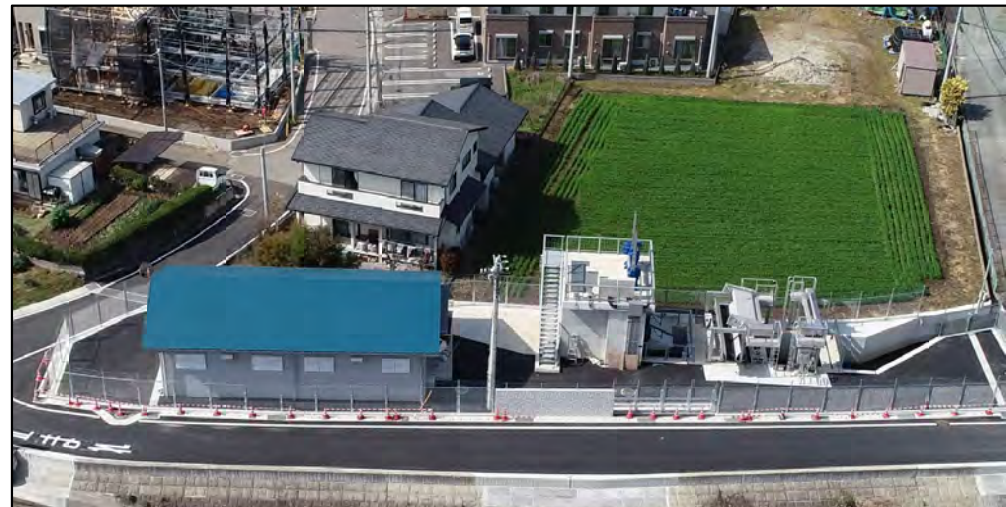
竣工(安永地区)
