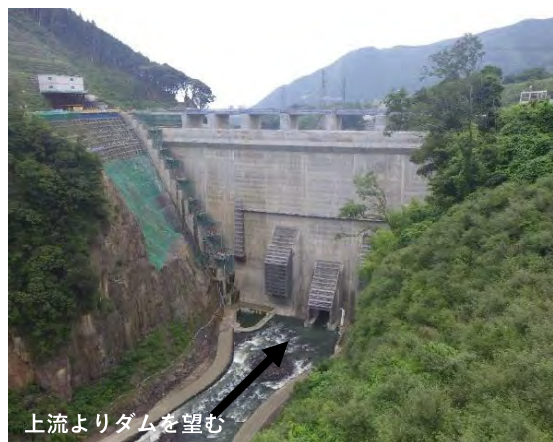
◆貯留状況写真
