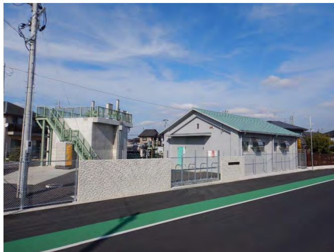
竣工(福富地区)
