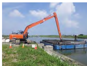
1/30 河道掘削 施工状況
