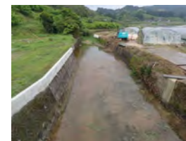
R6施工箇所
