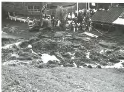
排水不良による法すべり
