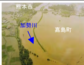
平成2年6月の浸水状況
