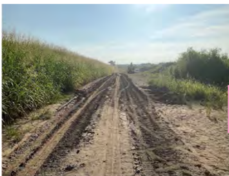
堆積した土砂 (着手前)
