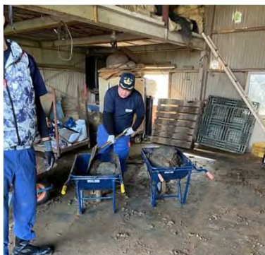
宇城市豊野町での 土砂撤去作業
