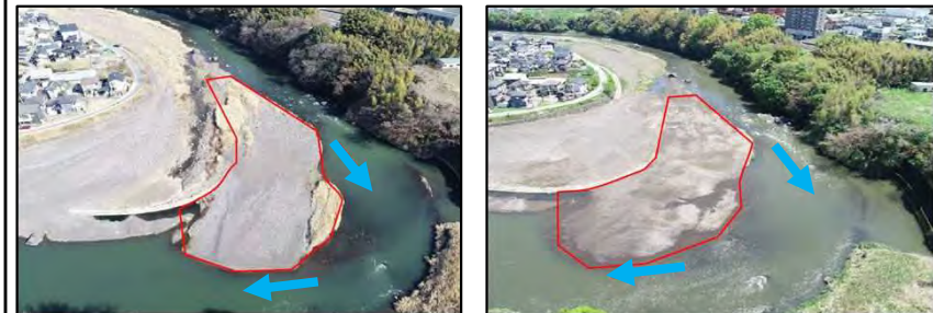
着工前 竣工後 ②白川(熊本市北区龍田地内)
