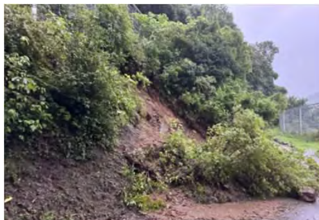
土砂崩れの状況
