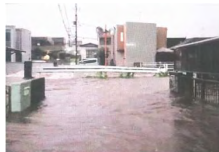
堀川（榎ノ本地区） 越水状況
