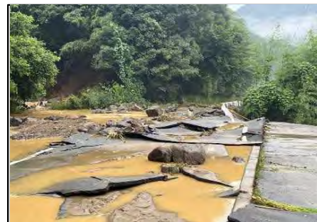
道路崩壊 (宮内地区)
