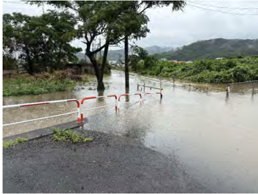
網津川支流（住吉町地先） 冠水状況
