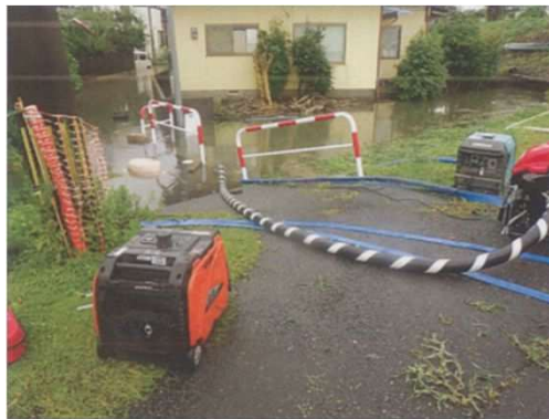
船場川支流（築籠町地先） 排水ポンプによる排水作業
