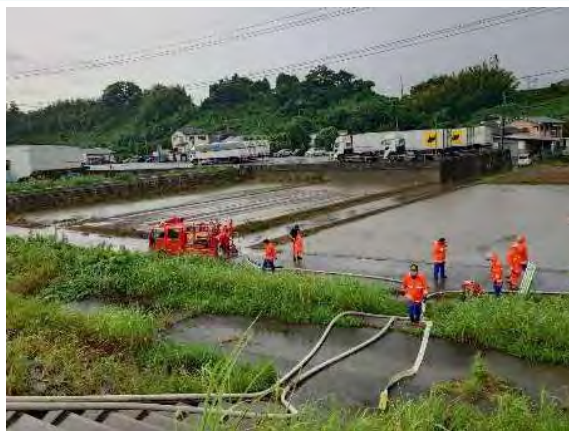
御船町(御船川左岸排水活動 R7.8.11)
