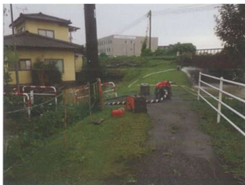
船場川支流（築籠町地先） 排水ポンプによる排水作業
