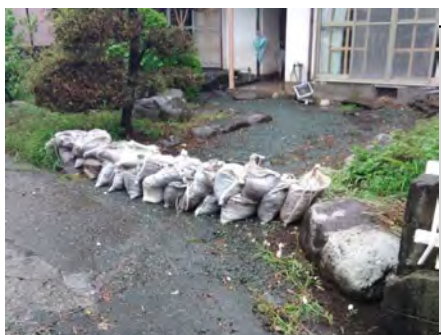
東ヶ丘 (津久礼2712地先) 積み土のう工
