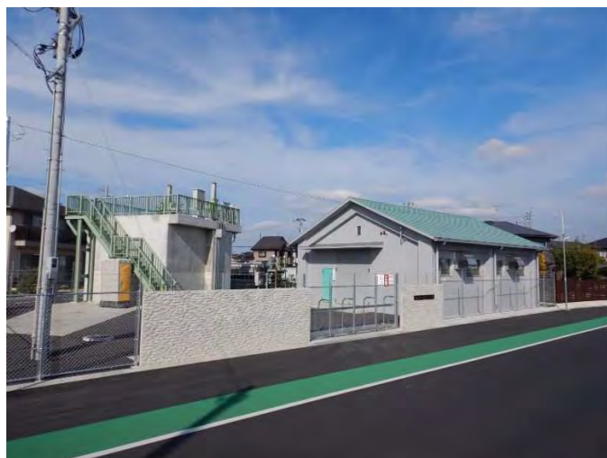
竣工(福富地区)
