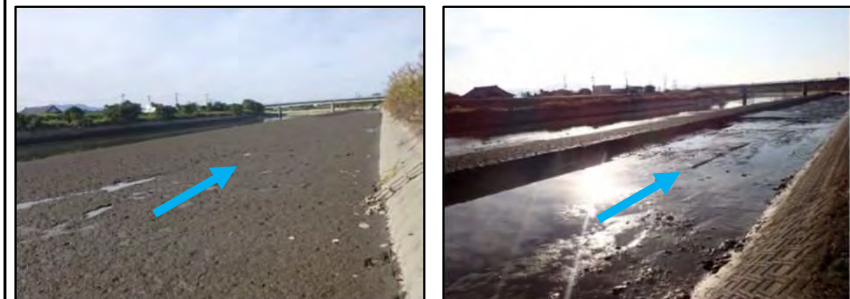
着工前 竣工後 ③浜戸川右岸(熊本市南区富合町小岩瀬地内)
