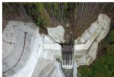
R5完成:五老ヶ谷砂防堰堤(美里町)
