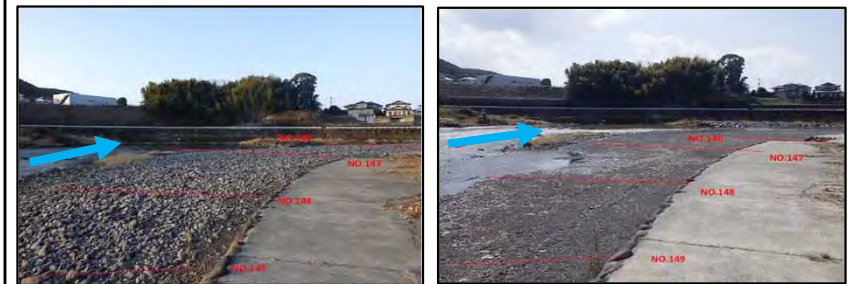
着工前 竣工後 ①白川(熊本市北区弓削地内)
