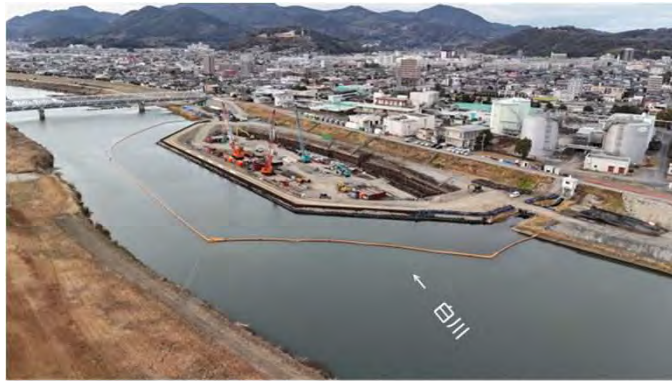
左岸上流側より撮影 R8.1月末時点
