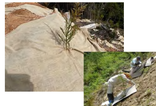
生分解性防草シートの実証施工(イメージ)
