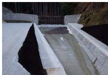
R6完成:山下川砂防堰堤(山都町)
