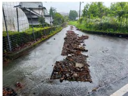
町道被災写真
