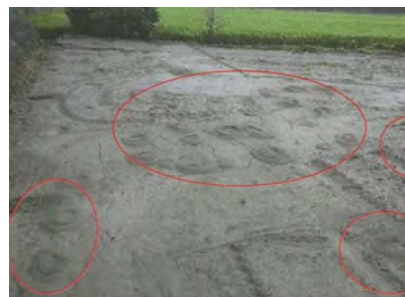
漏水による噴砂の例
