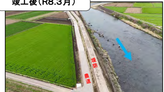
竣工後(R8.3月)
