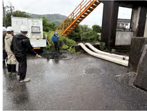
網津川支流（住吉町地先） 排水ポンプ車による排水作業
