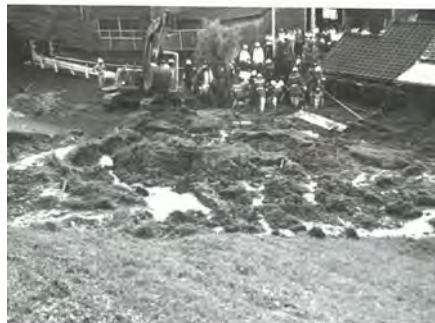
排水不良による法すべり
