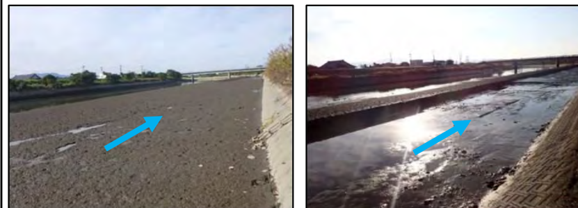
着工前 竣工後 ③浜戸川右岸(熊本市南区富合町小岩瀬地内)
