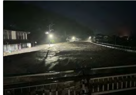
竜野川沿川の浸水被害 (中早川地区)
