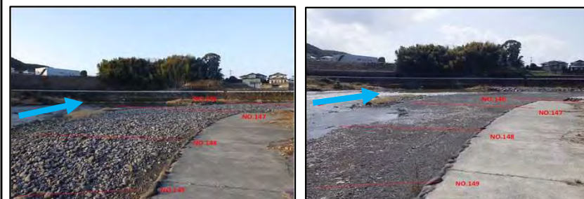
着工前 竣工後 ①白川(熊本市北区弓削地内)
