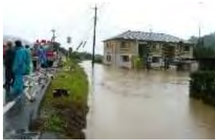
馬門川付近の浸水被害状況(H19.7豪雨)
