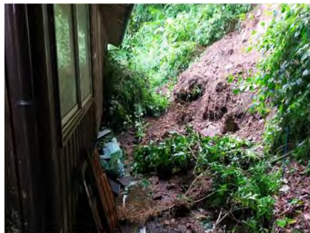
民家敷地裏の被災写真
