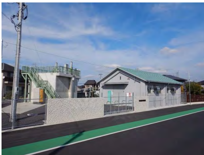
竣工(福富地区)
