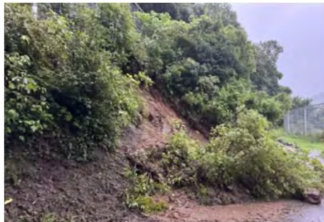
土砂崩れの状況
