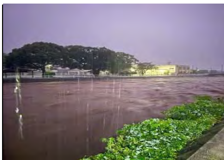
木山川 増水状況 (津森小学校前)
