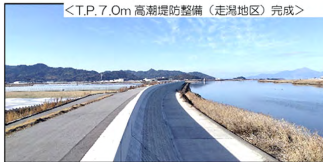
高潮堤防整備状況 （緑川下流左岸：TP 7.0対応）
