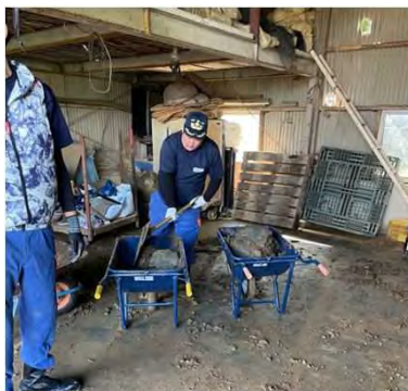
宇城市豊野町での 土砂撤去作業
