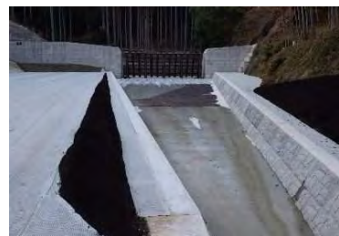
R6完成:山下川砂防堰堤(山都町)
