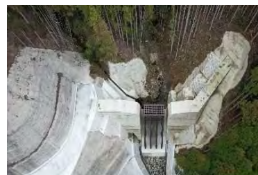
R5完成:五老ヶ谷砂防堰堤(美里町)
