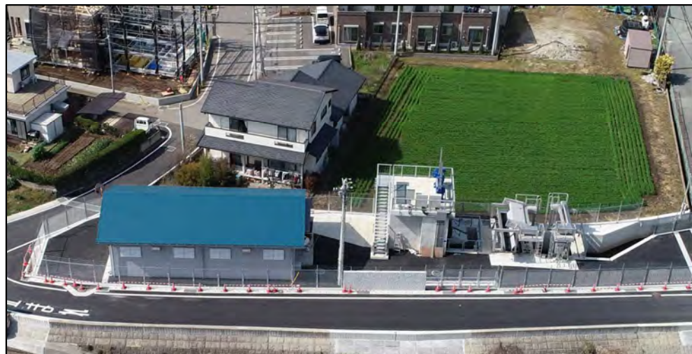
竣工(安永地区)
