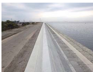
高潮堤防の整備状況
