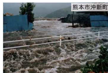
平成11年の台風18号による堤防の越水状況
