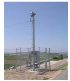
CCTV カメラの設置事例
