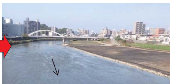
河道内に堆積した土砂の撤去状況（白川橋下流左岸）
