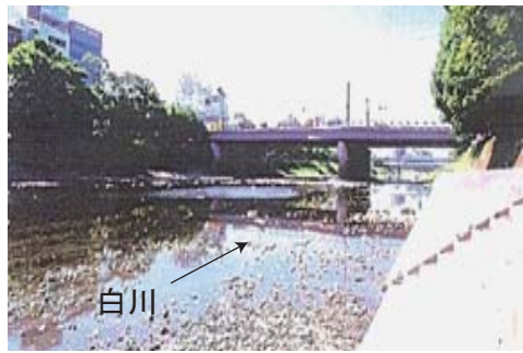
平成6年渇水時の瀬切れの状況（大甲橋）
