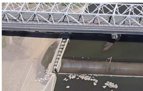
十八口堰の魚道
