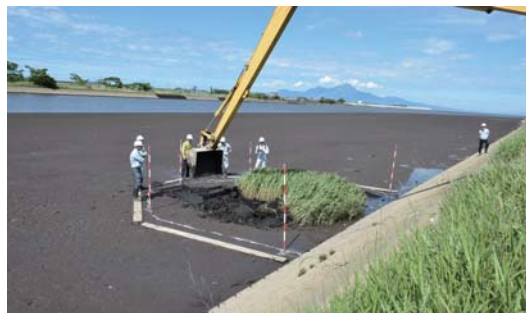
ヒガタアシの除去作業
