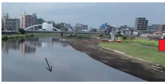
河道内に堆積した土砂の撤去状況（白川橋下流左岸）
