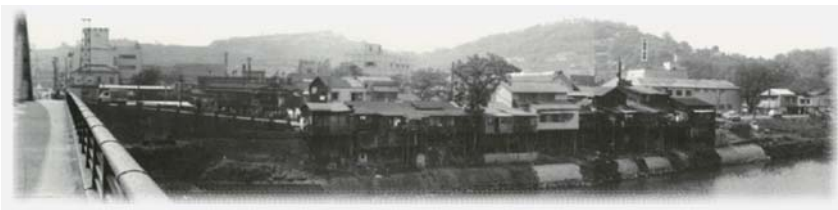
不法占用により河川区域内に家屋が密集(昭和44年)
