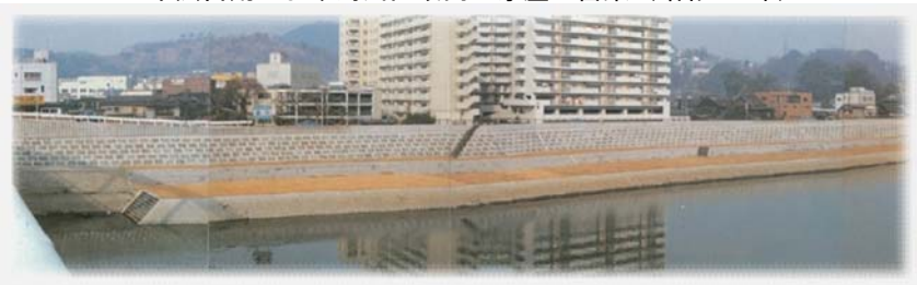
不法占用家屋を撤去し、河道拡幅を行った上で護岸を整備(昭和58年)
