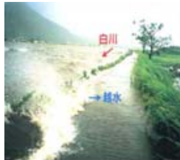
平成 11 年の台風 18 号による堤防の越水状況 （熊本市沖新町：国土交通省熊本工事事務所資料）
