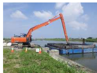
1/30 河道掘削 施工状況
