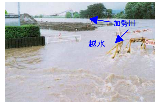
平成2年6月の越水状況
