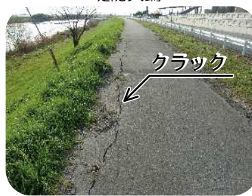
補修対策を必要とする河川管理施設 (クラック*の発生状況)
