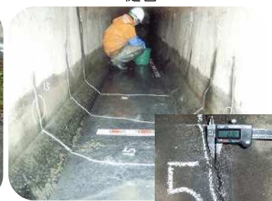
補修対策を必要とする河川管理施設 (クラック*の発生状況)
