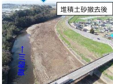
土砂堆積部の河道管理 (御船川での実施例)
