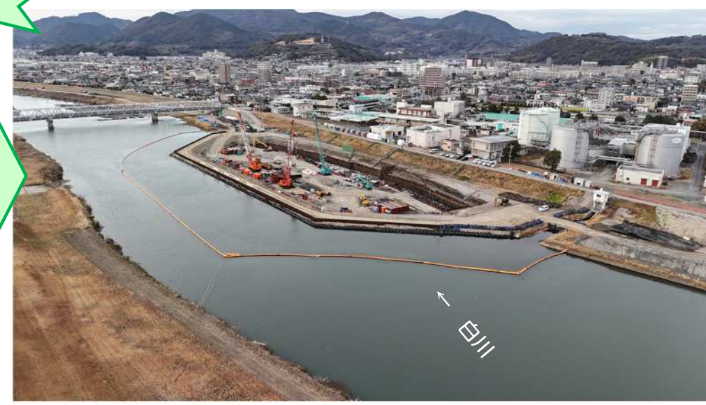
左岸上流側より撮影 R8.11月末時点
