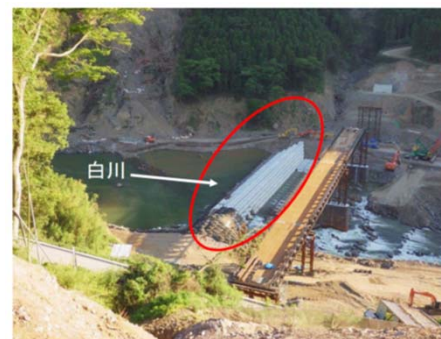
土砂捕捉施設（遠景）
