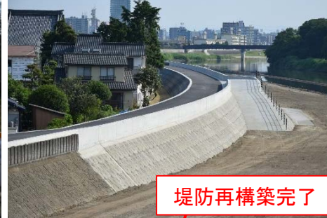
白川右岸 蓮台寺地区(熊本市西区)
