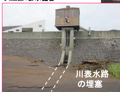
堆積土砂の撤去状況 (国管理区間: 蓮台寺橋上流)
