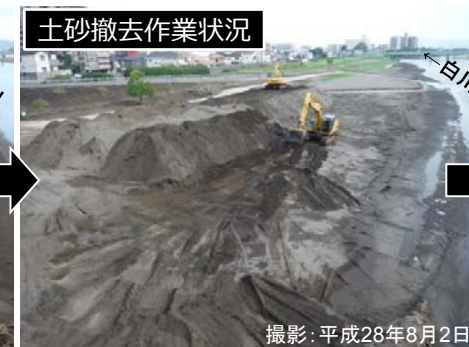
堆積土砂の撤去状況 (国管理区間: 白川橋下流)
