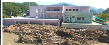
岩手県小本川被災状況 (台風10号H28.8.30)
