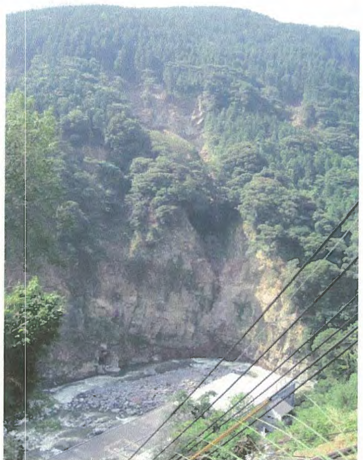
排水路出口のすぐ下流に、25の断層と思われる亀裂が山の上から走っている 2016年7月2日撮影
