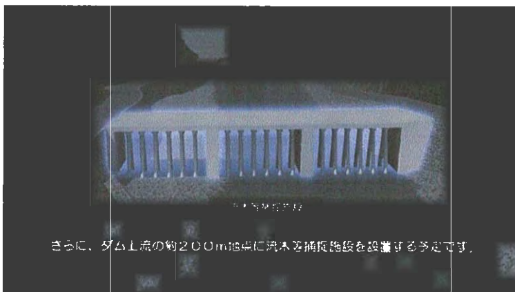
国交省動画「立野ダムの洪水調節」より 流木等捕捉施設。
