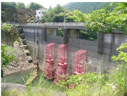
原野谷川農地防災ダム（静岡県）
