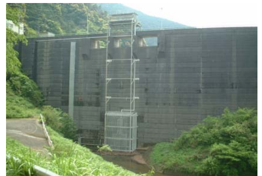
大代川農地防災ダム（静岡県）
