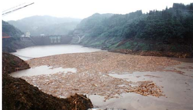
写真－２ 貯水池内の流木状況
