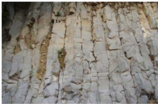
地表の部分は掘削して除去
