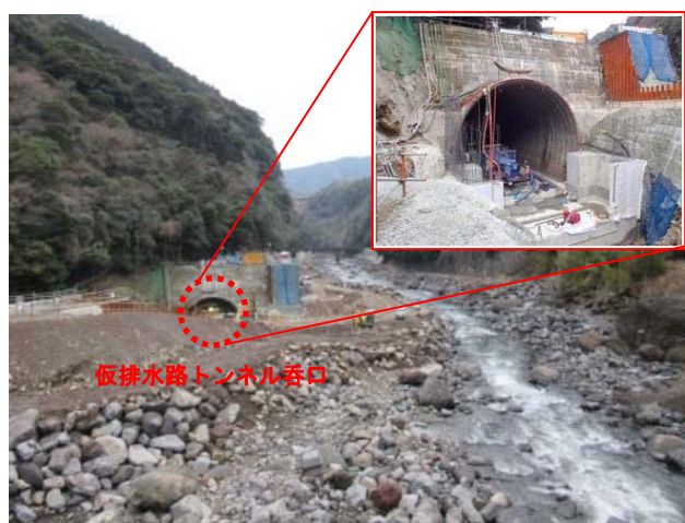
写真－３ 仮排水路トンネルの状況（地震
