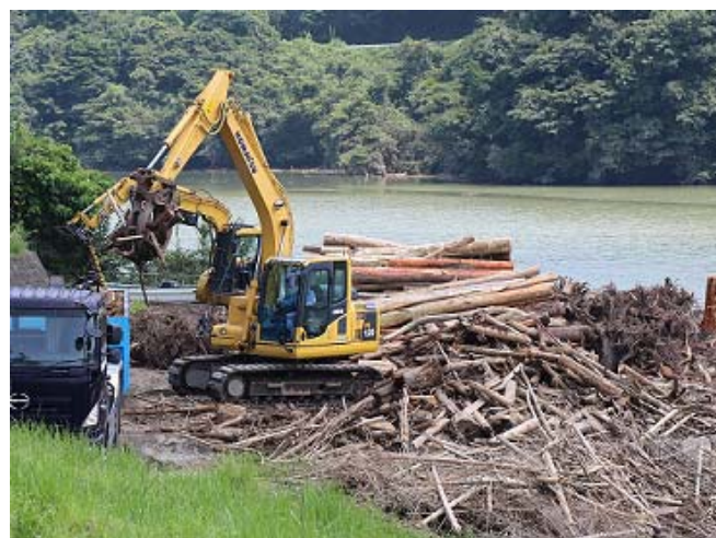
写真－４ 流木の回収状況
