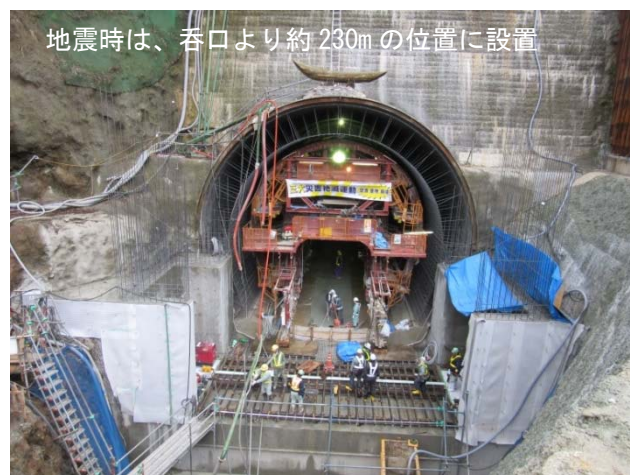
写真－２ 型枠の設置状況（地震前）
