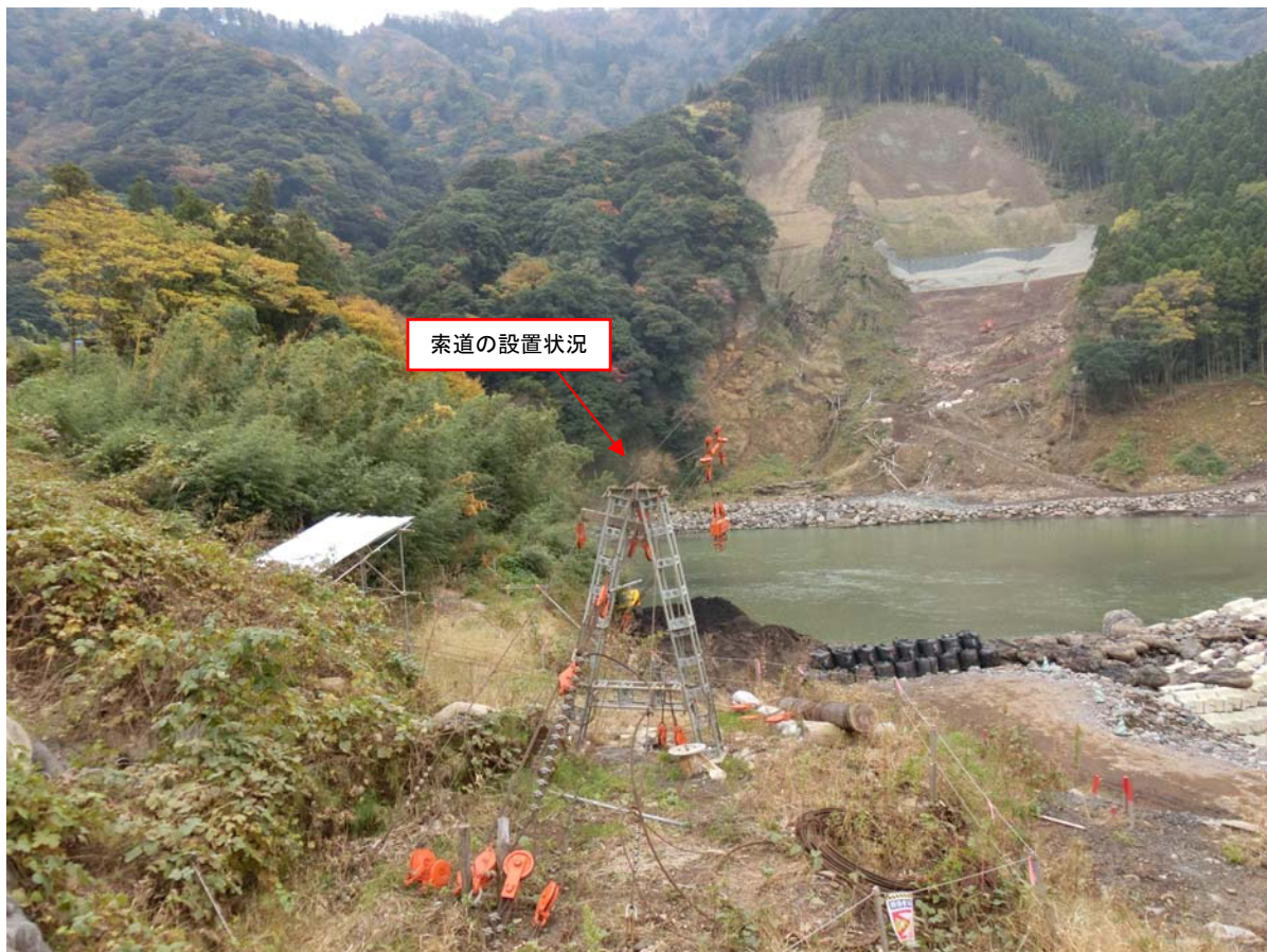
写真－３ 斜面对策の施工状況
