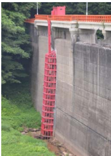
外柵沢ダム（岩手県）
