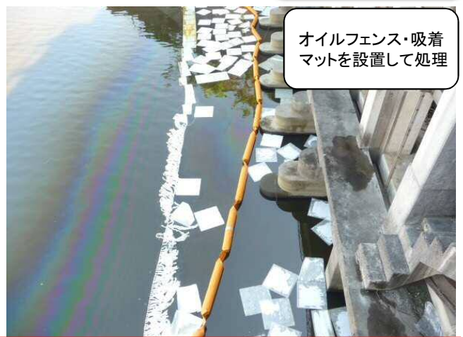
送油管の老朽化等による亀裂・破損箇所から油が排水路に流出!!!
