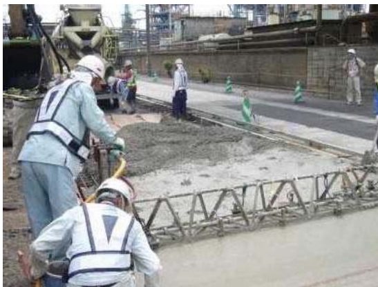
簡易フィニッシャによる施工事例
