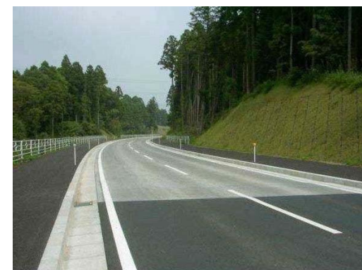
県道成田小見川鹿島港線 千葉県香取市※3 (ポラスコンクリート舗装※4)
