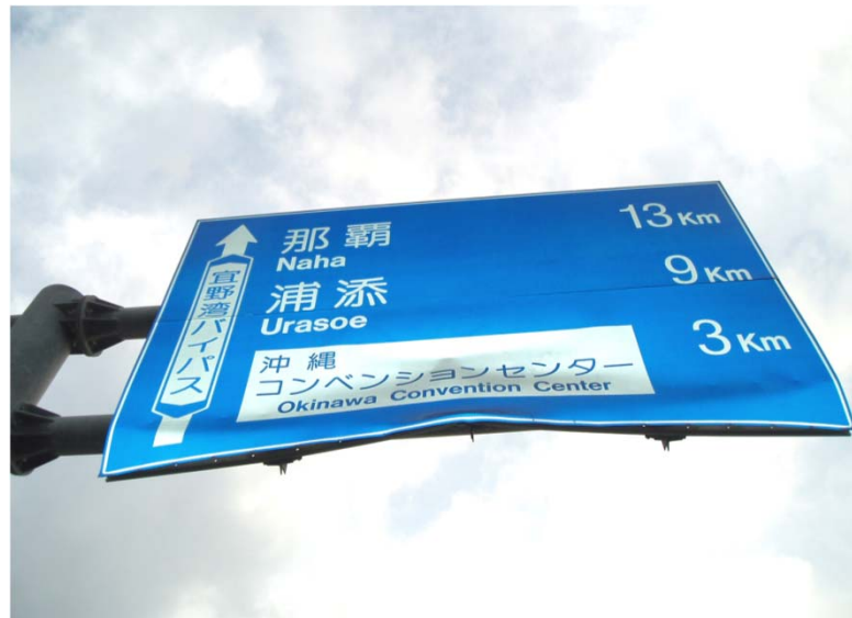
異常変形 (車両衝突)
