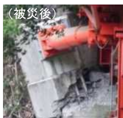
制震ダンパー取付部の損傷
