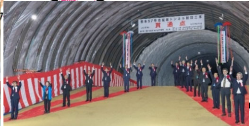
▲トンネル貫通式 (R5. 6. 18)
