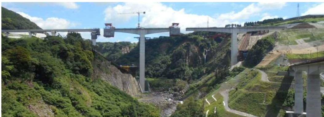
橋桁の端部が橋脚上にない状態でも橋桁が落ちない状態を保っている新阿蘇大橋(施工中)
