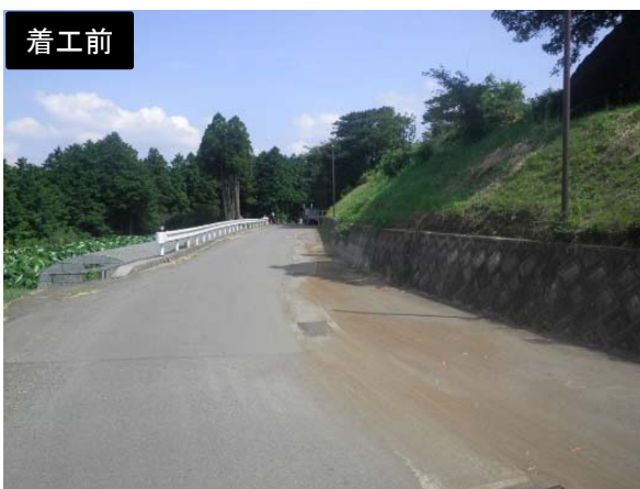
①袴野地区工事用道路整備工事【工事完了】
