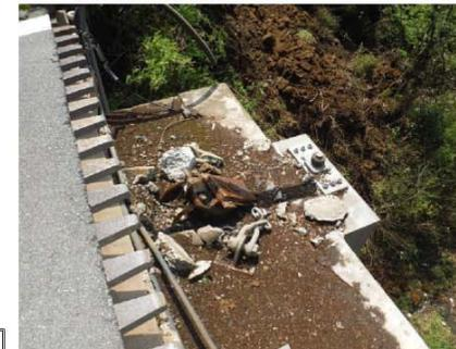
④A2橋台側支承損傷状況
