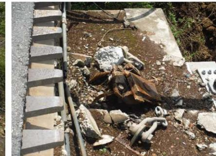
⑤A2橋台背面部損傷状況
