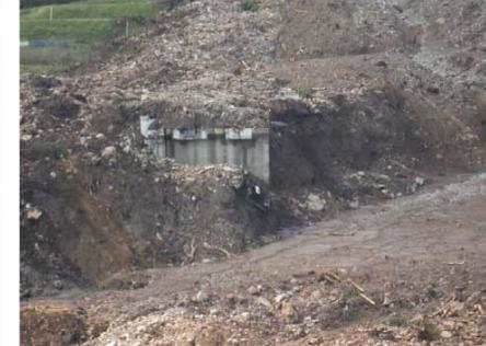
③A2橋台橋座部損傷状況
