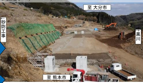
●補強土壁 コンクリートパネル設置(H30.3)
