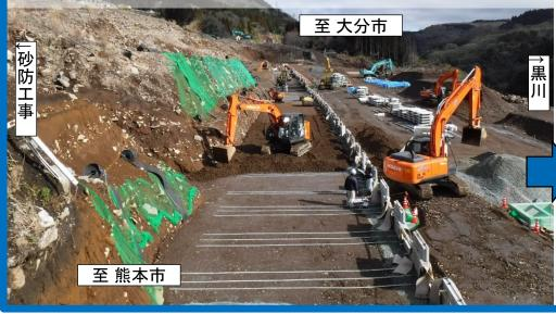
●補強土壁 嵩コンクリート打設(H30.8完了)
