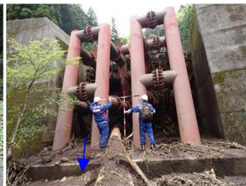
砂防堰堤下流側より
