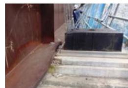
上部取付部の破壊に伴い鋼桁が橋座に脱落して変形
