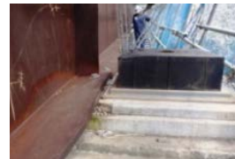
下部取付部で破壊させて段差と主桁への影響を最小化
