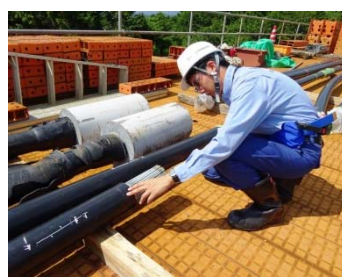
ケーブル内部の素線状況の調査
