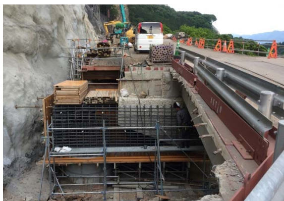
増し杭による水平抵抗力の確保
