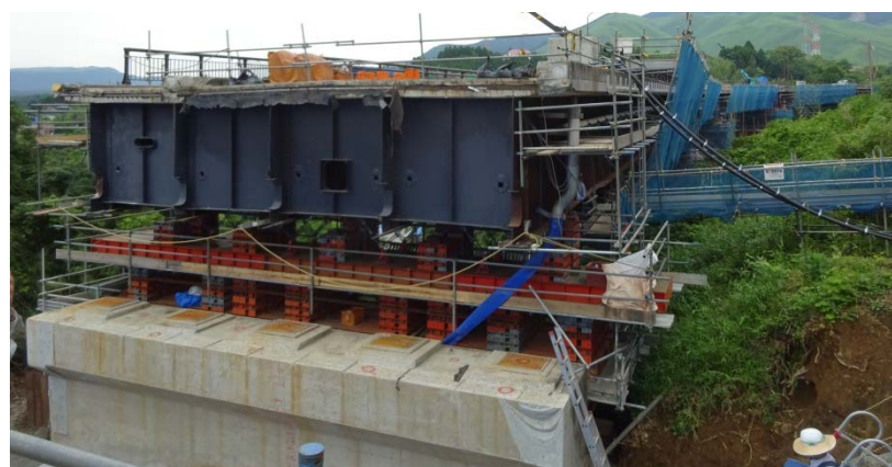
4000tの上部構造をジャッキアップして復旧工事中の大切畑大橋
