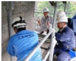
つくばの国総研・土木研究所の研究部と連携し高度な技術支援を実施
