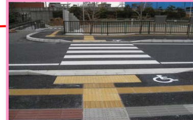
②横断歩道乗入縁石段差
