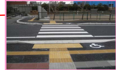
② 横断歩道乗入縁石段差
