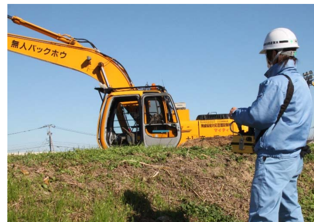
遠隔操縦式バックホウ操作状況
