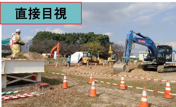
遠隔操縦式バックホウによる無人化施工機械操作体験
