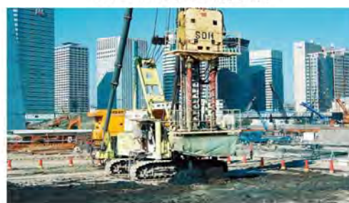
SDM-Fit 排土状況
