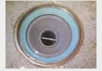
③取付工（設置～金物取合いコーキング～養生～完了： 全工程は約1時間）
