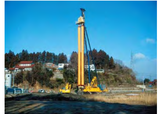
SDM-FitⅣ施工状況
