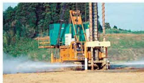
SDM-Fit 高圧噴射状況
