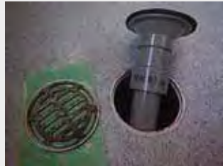
③取付工（設置～金物取合いコーキング～養生～完了： 全工程は約1時間）
