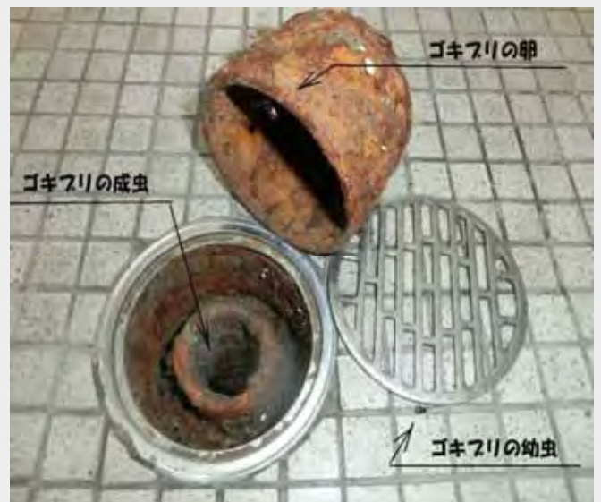
封水が無くゴキブリほか害虫・悪臭 発生環境
