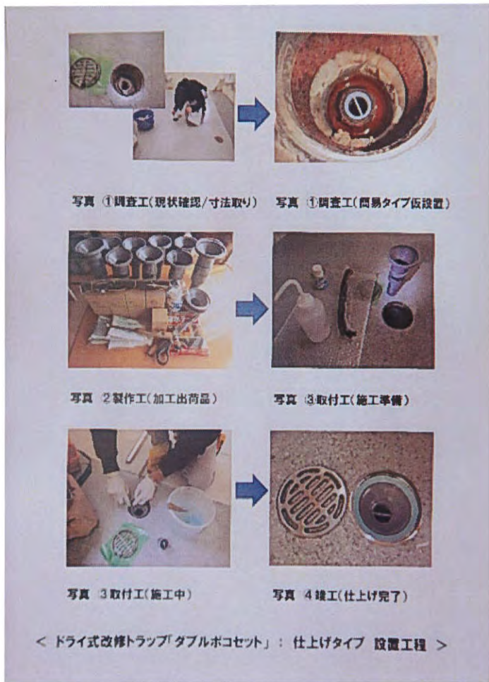
図4: ドライ式改修トラップ工法 施工流れ
