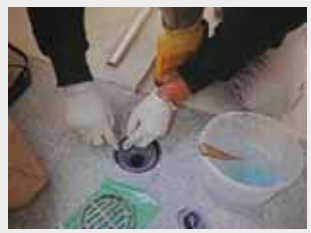
③取付工（設置～金物取合いコーキング～養生～完了： 全工程は約1時間）
