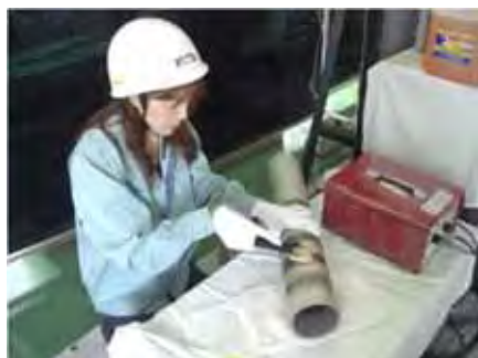
ステンレス製パイプの 溶接焼け取り作業
