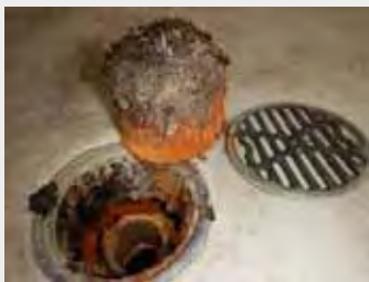
内部堆積物で排水不良
