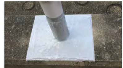
⑥施工完了
