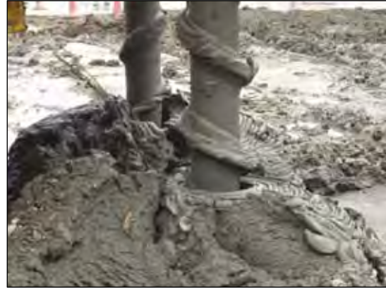
投入セメント量に見合う、原土の排出。
