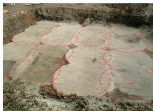
SDM-Fit 改良体状況
