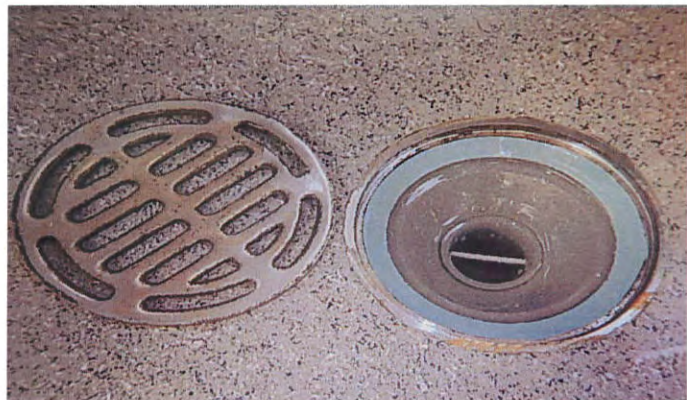
図6: ドライ式改修トラップ 完成事例
