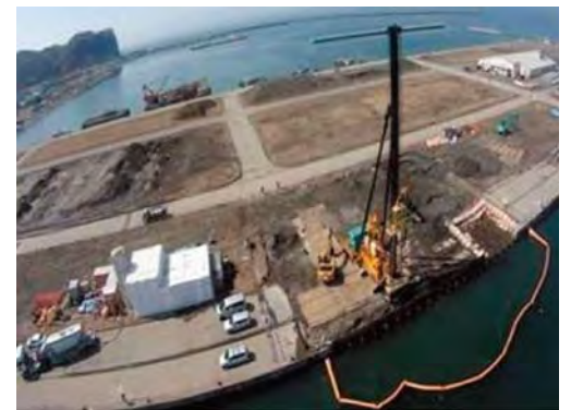
SDM-FitⅡ施工状況
