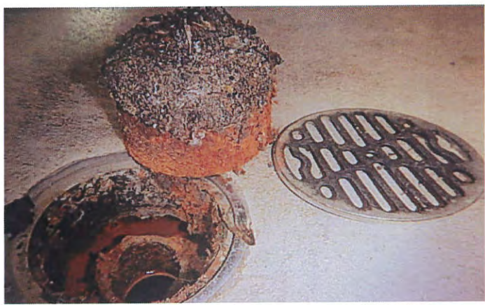
図2: 金属腐食・排水不良のT5排水金物
