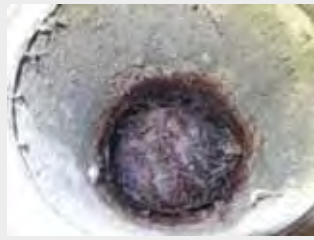
①調査工（金物内部取合い～簡易ドライ式トラップ仮設置）
