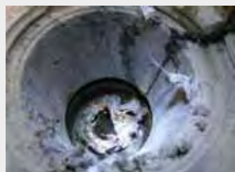
内部保守・清掃が困難（トラップ部が深すぎる）
