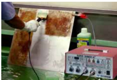
ステンレスの錆取り作業 (錆を取り、再発を防止)
