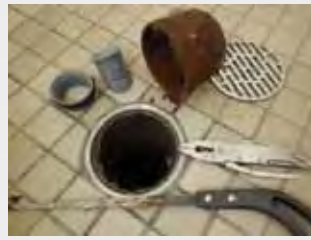
①調査工（金物内部取合い～簡易ドライ式トラップ仮設置）
