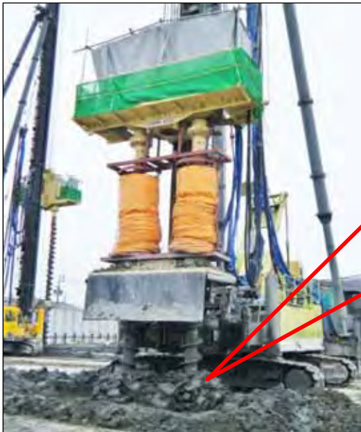
投入セメント量に見合う、原土の排出。
