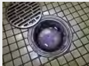
腐食破損で椀取手無し (錆固着もあり椀脱着不可)
